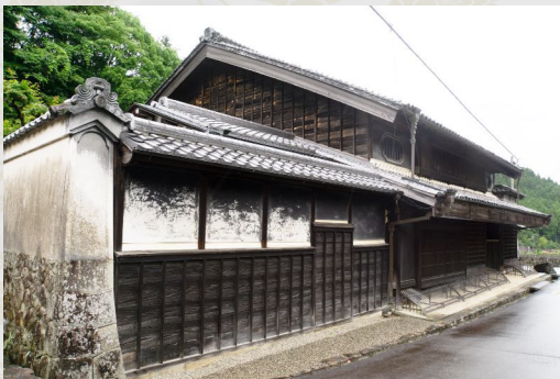
【田中家住宅主屋】 切妻造棧瓦葺の二階建てで、一階に格子、二階に虫籠窓と出格子を並べる。
